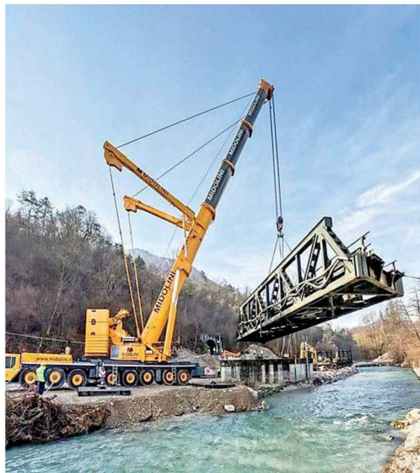
Una gru di Midolini Group al lavoro sul cantiere di una tratta ferroviaria della provincia di Belluno
